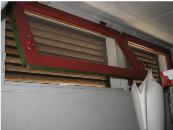
Foto 39 tv: Køkkenvindue, indadgående med tremmeværk udenfor.
