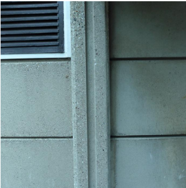
Foto 27 tv: Detalje af betonelement facaderne med de synlig søjler.
