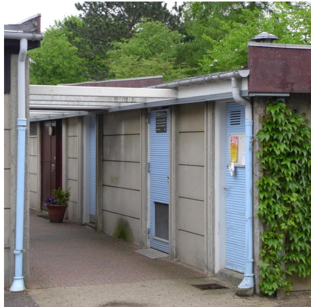
Foto 48 th.: De oprindelig listebeklædte døre til affaldsrum, vaskeri og depoter ved en af pergolastiens indgang.
