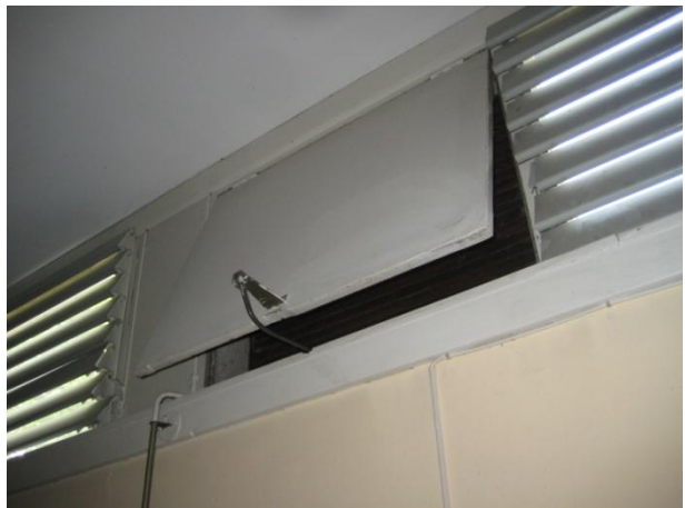
Foto 36 th.: Oprindeligt har både have- og "bag"-facade haft lukkede udluftningspartier. Her ses et bevaret udluftningsparti ved spisepladsen.
