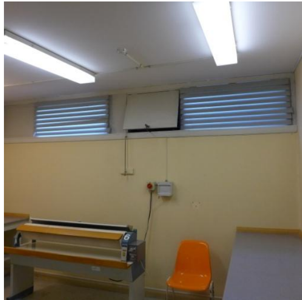
Foto 45 tv: Fra fællesvaskeriet med de oprindelig åbne tremmewægge til tørrerummene.
