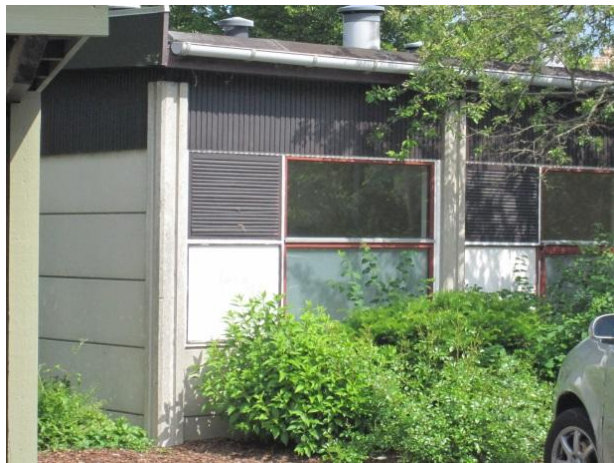
Foto 23 tv: Havefacade i dag. Beboerne har haft delvis valgfrihed mht. bevarelse og opspudsning af de lukkede felter (udluftningspartier), men højden på den lette brystning og vinduerne er bevaret.
