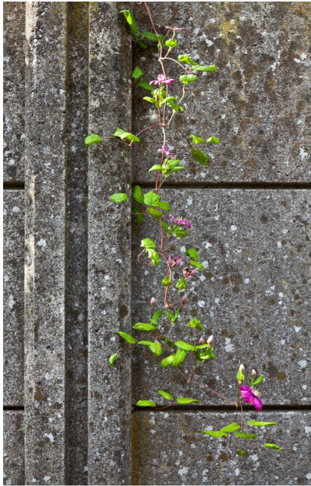
Foto 32 th: Detalje af facadesøjle og – elementer. De ubehandlede betonelementer har let patineret og står uden synlige skader
