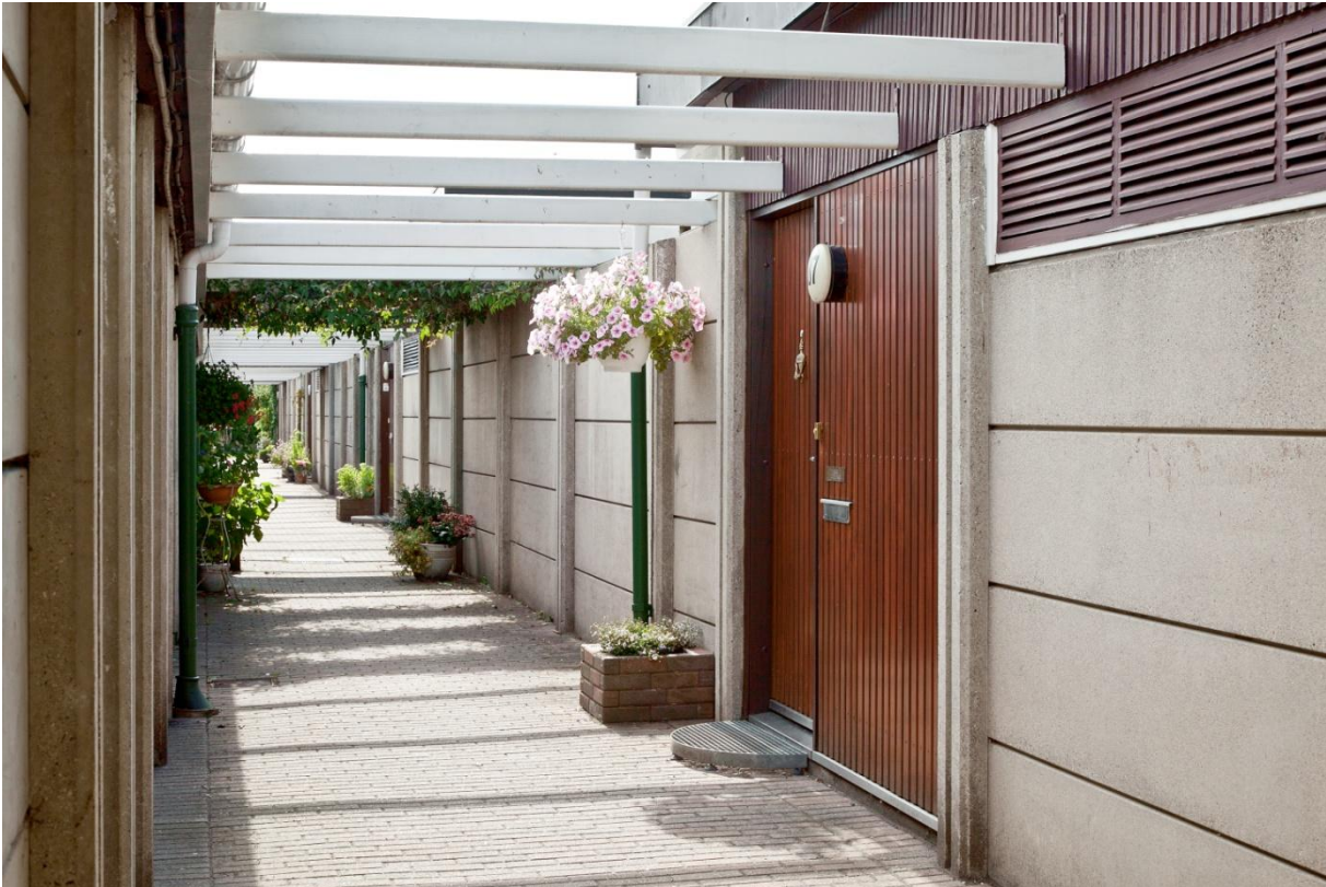
Foto 19. Betonelementerne er omsorgsfuldt detaljeret og kombineret med spinkelt dimensionerede trævinduer og facadeudfyldninger.
