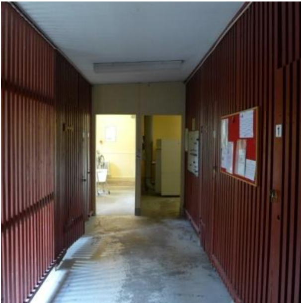
Foto 45 tv: Fra fællesvaskeriet med de oprindelig åbne tremmewægge til tørrerummene.
