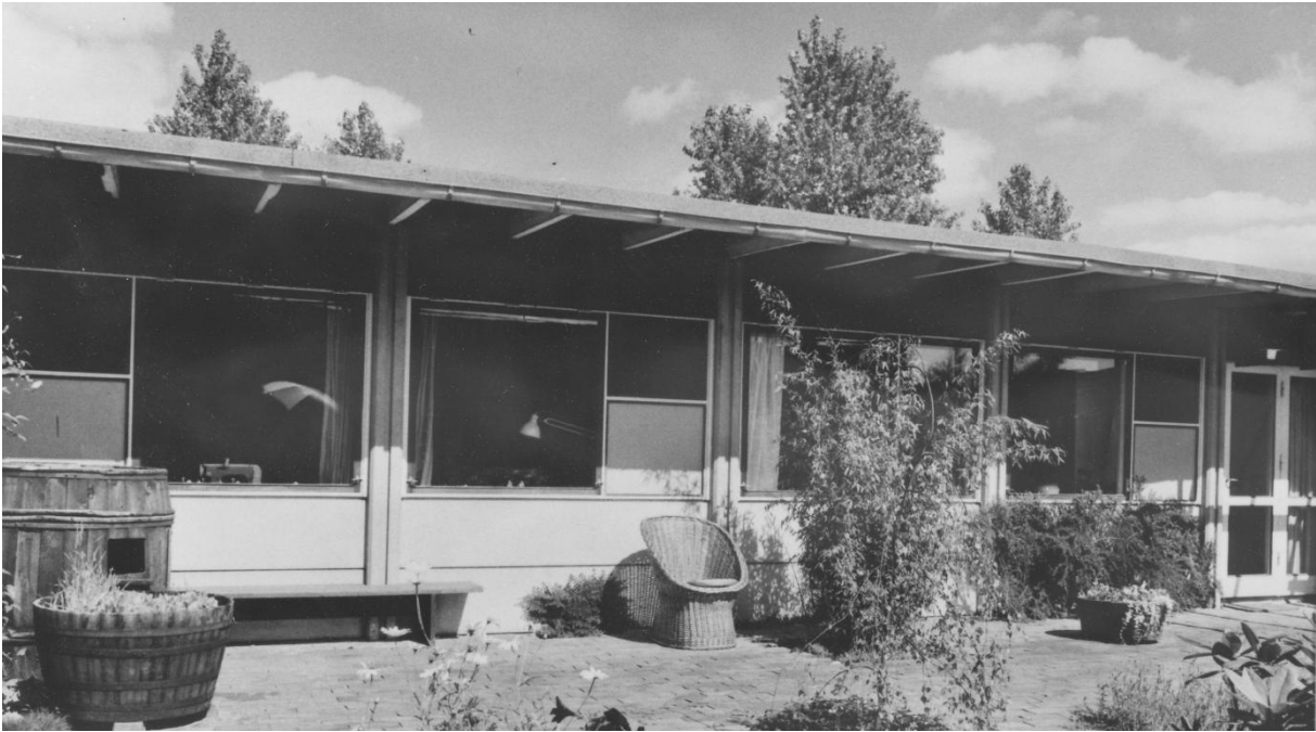
Foto 22. En havefacade med de oprindelige facader. Sammenlign med de nye havefacader, f.eks. side 2 og nedenfor
