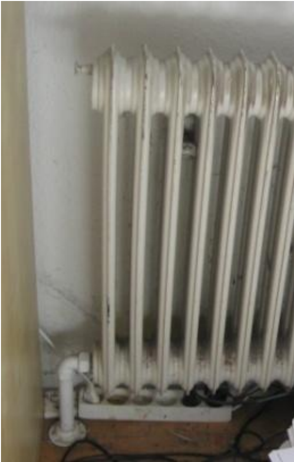
Foto 43 tv: Oprindelig støbejerns radiator i værelse.
