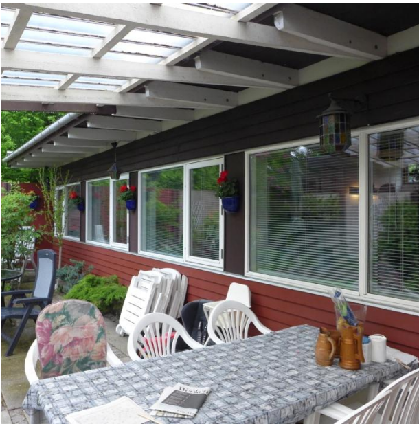
Foto 23 tv: Havefacade i dag. Beboerne har haft delvis valgfrihed mht. bevarelse og opspudsning af de lukkede felter (udluftningspartier), men højden på den lette brystning og vinduerne er bevaret.
