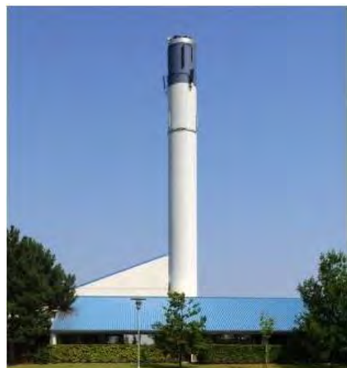
Farum Fjernvarme a.m.b.a. Stavnsholtvej 33, 3520 Farum
